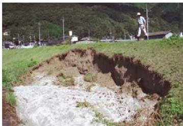
写真 2-3-8 洪水による堤防の損傷
