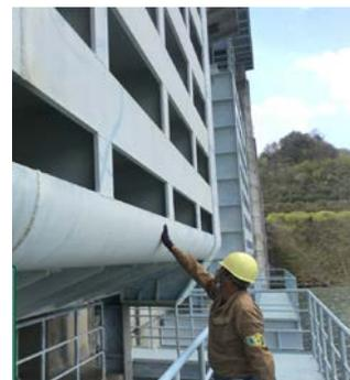
写真 2-3-5 ゲート扉体の点検状況
