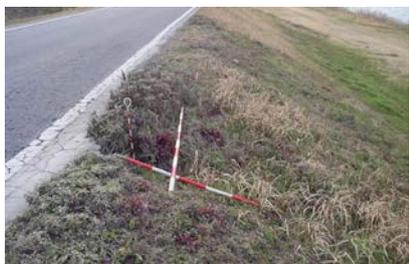
写真 2-3-1 堤防の陥没
