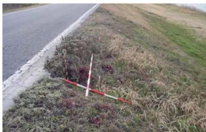
写真 2-3-1 堤防の陥没
