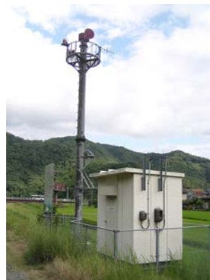
写真 5-2-17 八田原ダム放流警報設備
