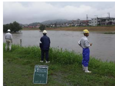
写真 5-2-27 洪水時の巡視状況
