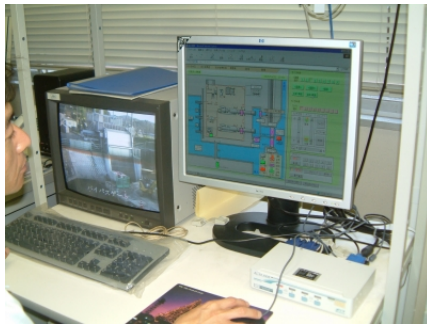
12 写真 5-2-29 排・取水門の遠隔操作状況
