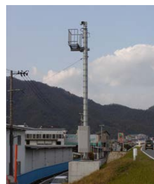
写真 5-2-11 CCTV の設置状況
