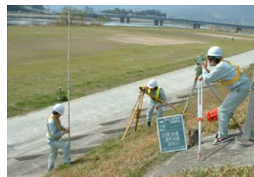
写真 5-2-4 縦横断面測量
