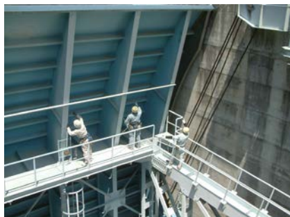
23 写真 5-2-16 クレストゲートの点検状況
