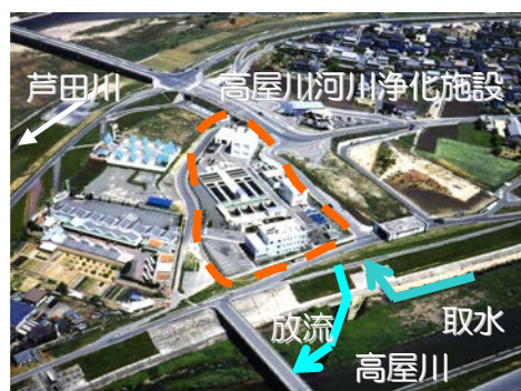
写真 5-1-9 高屋川河川浄化施設
