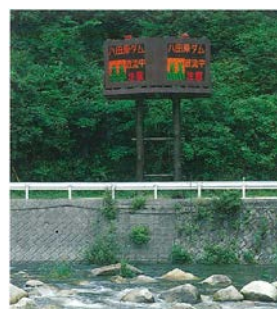
写真 5-2-35 八田原ダム情報掲示板
