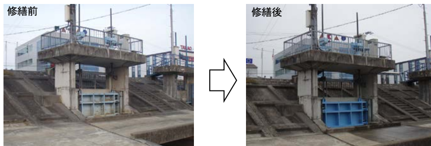
写真 5-2-10 排水門の修繕状況 (岩成悪水樋門) いわりあくすい
