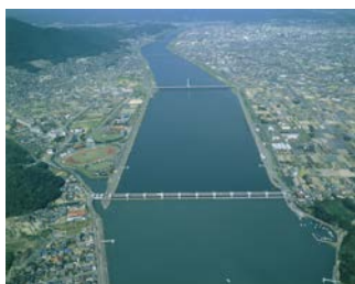
写真 2-2-25 芦田川河口堰と湛水区間
