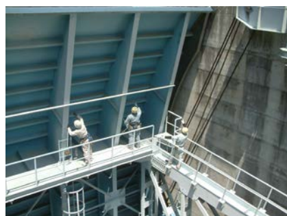
23 写真 5-2-16 クレストゲートの点検状況
