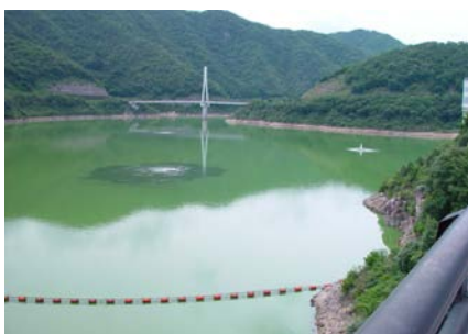
写真 2-2-36 アオコの発生状況（八田原ダム）
