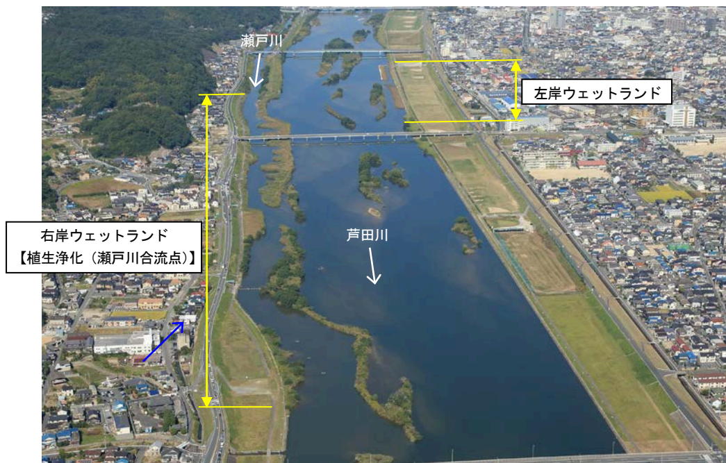
写真 5-1-10 植生浄化の整備状況
