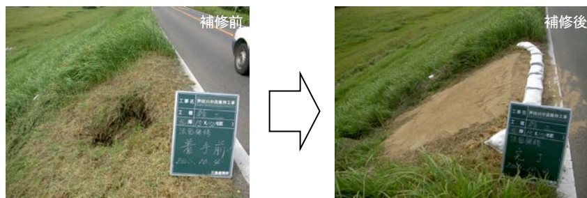
写真 5-2-8 堤防の補修状況
