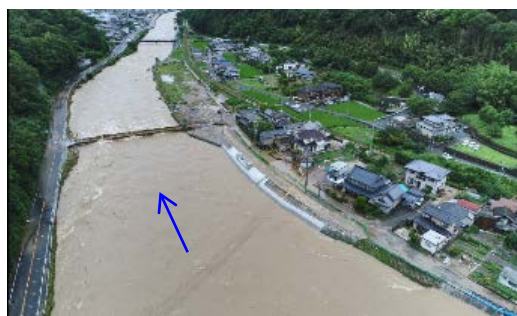
府中市父石町付近の浸水状況
