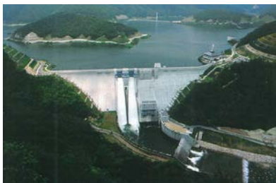
写真 1-2-4 八田原ダム (平成 10 年 3 月完成)
