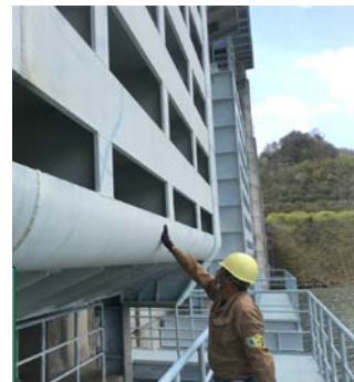
写真 2-3-5 ゲート扉体の点検状況
