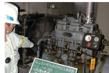
写真 5-2-3 排水機場の点検状況
