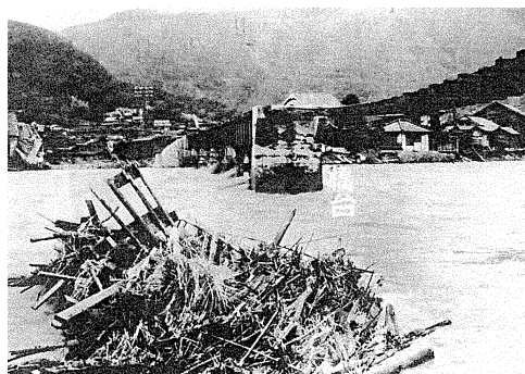
府中市父石町の浸水状況
