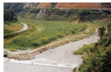
写真 5-1-11 植生浄化施設
