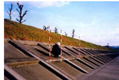
写真 5-2-5 洪水痕跡調査
