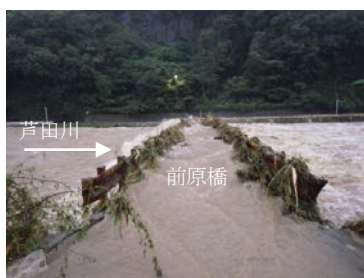
写真 2-1-1 平成 30 年 7 月豪雨の状況
