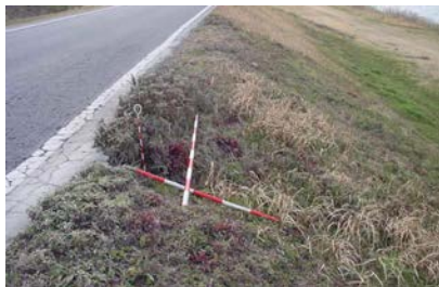
写真 2-3-1 堤防の陥没
