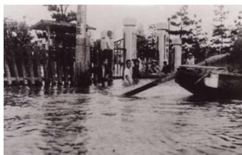
南小学校前の浸水状況
