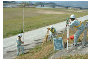
写真 5-2-4 縦横断面測量
