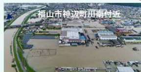
平成30年7月豪雨での被害状況
