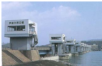
写真 1-2-3 芦田川河口堰 (昭和 56 年 6 月完成)
