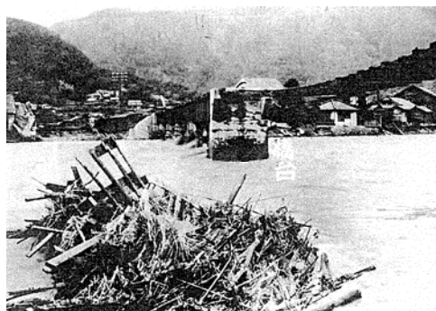
府中市父石町の浸水状況
