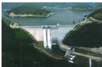
写真 1-2-4 八田原ダム (平成 10 年 3 月完成)
