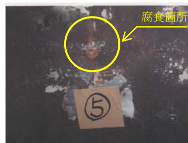
写真 2-3-5 放流管の劣化状況
