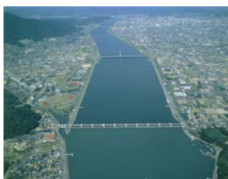
写真 2-2-24 芦田川河口堰と湛水区間
