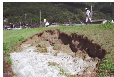
写真 2-3-10 洪水による堤防の損傷
