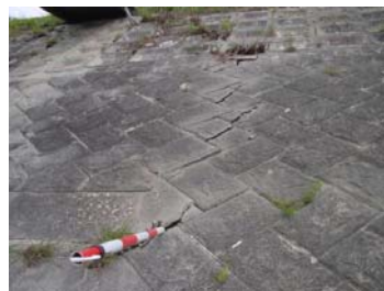
写真 2-3-2 老朽化による護岸のクラック
