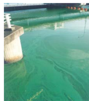
写真 2-2-35 アオコの発生状況 (芦田川河口堰)
