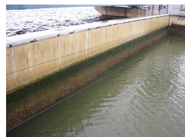
写真 2-3-6 主ゲートの劣化状況
