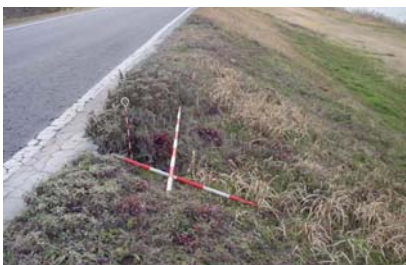
写真 2-3-1 堤防の陥没
