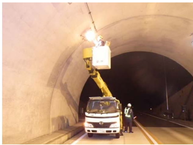
トンネル照明灯のランプ球替え
