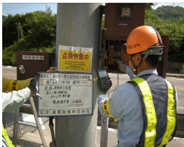
道路情報板の点検状況
