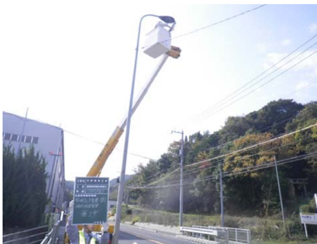
道路照明灯のランプ球替え
