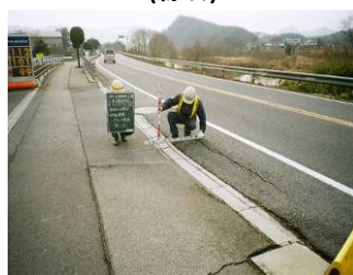
小構造物等の補修 (縁石)
