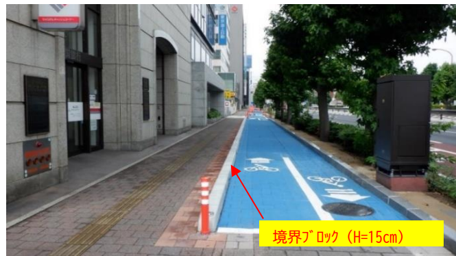
【写真①】整備後
