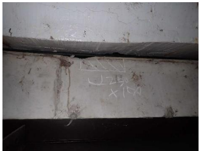
【損傷状況：床版のうき】
