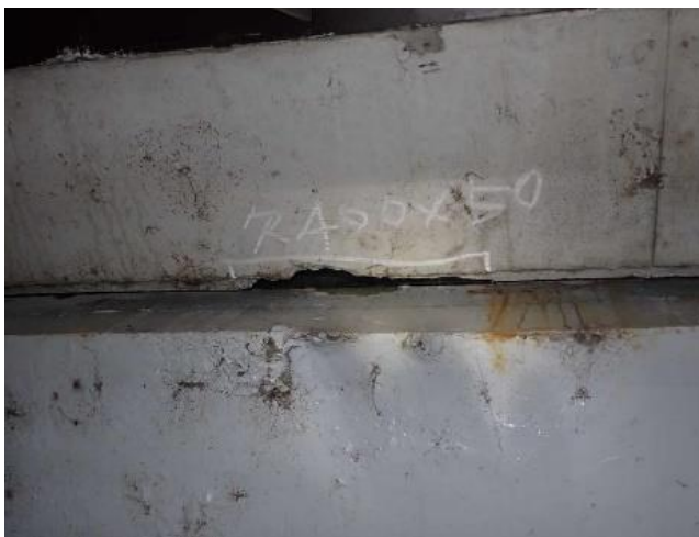
【損傷状況：床版の剥離・鉄筋露出】
