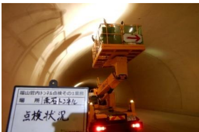
トンネル点検
