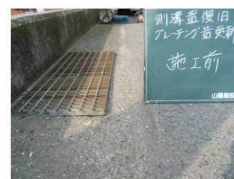
小構造物等の補修 (側溝)
