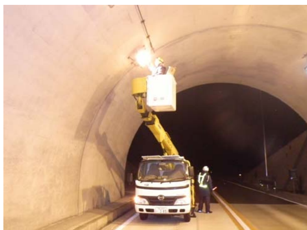
トンネル照明灯のランプ球替え
