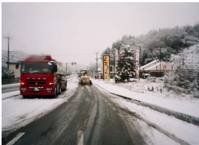
除雪（平成26年2月）
