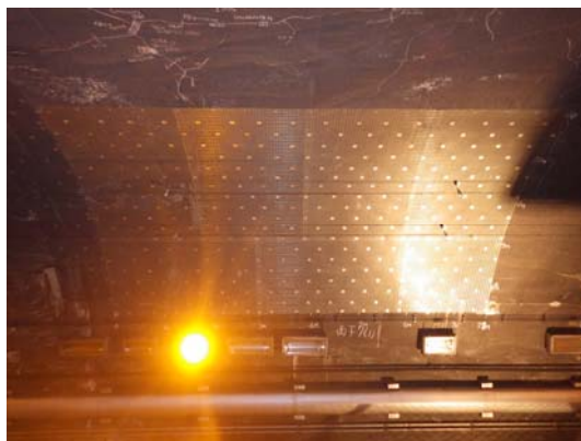
頂版部の剥落防止ネット設置
