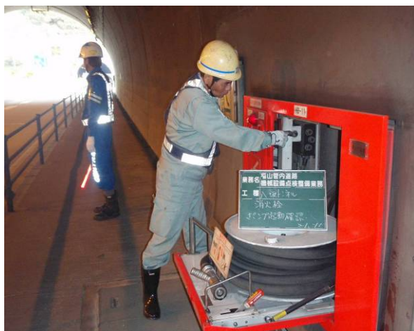
トンネル消火ポンプ点検状況
