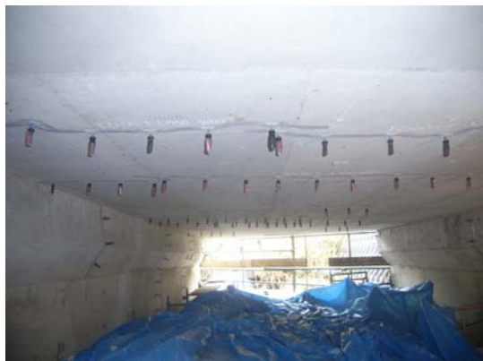
橋桁下面のひび割れ注入
