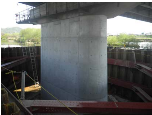
橋脚補強工
