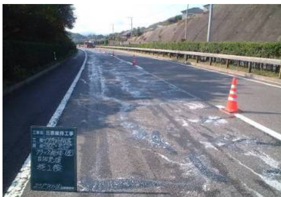
ひび割れ補修材注入
