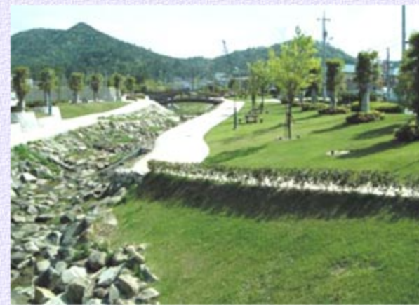
2級河川高尾川の整備後
