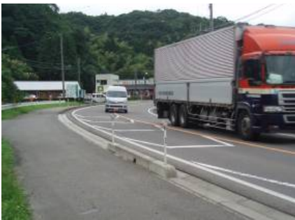
【写真①】 線形不良箇所（国道313号）
