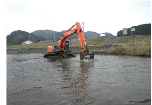
重機による河道攪拌
