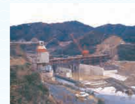
進む建設工事(昭和47年度)
