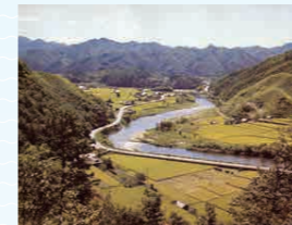
着工前のダムサイト(昭和41年頃)
