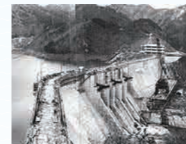
完成間近(昭和49年2月)
