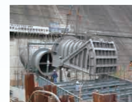
低位放流設備(施工中)(平成19年)
