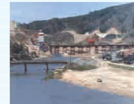
仮設備、基礎掘削、付替道路の工事本格化(昭和46年度)
