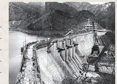
完成間近【昭和49年2月】
