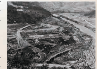
堤外仮排水路工事【昭和45年頃】
