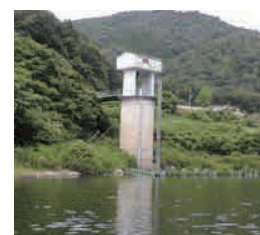
分水取水施設
