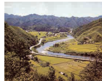
着工前のダムサイト【昭和41年頃】
