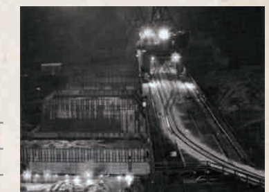
夜間コンクリート打設【昭和47年10月】
