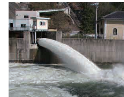
④利水放流設備
