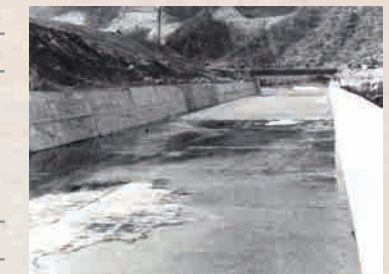
堤外仮排水路完成【昭和46年4月】
