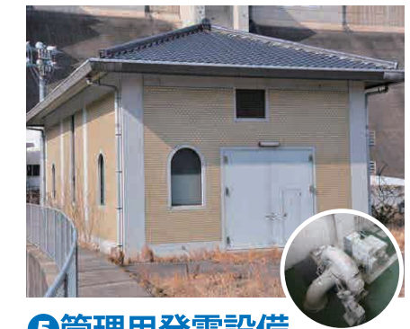
⑤管理用発電設備
