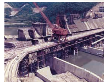
工事最盛期【昭和48年7月】
