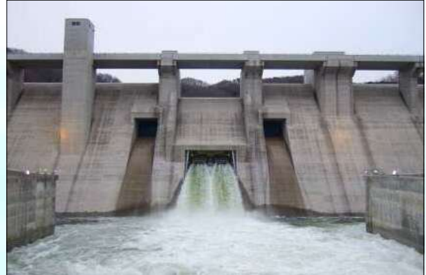
灰塚ダムのフラッシュ放流状況
