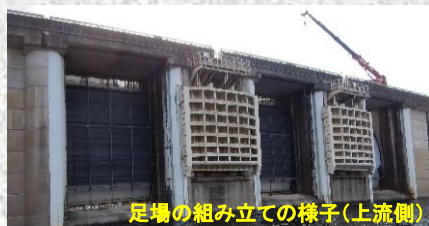
足場の組み立ての様子(上流側)
