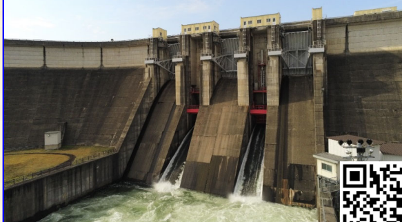
オリフィスゲートから放流中 (ドローンによる撮影)
