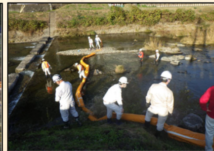
オイルフェンス設置訓練①
