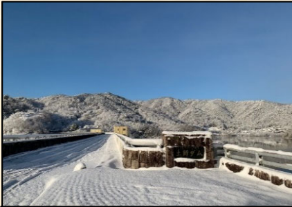
1月10日 土師ダム堤頂道路
