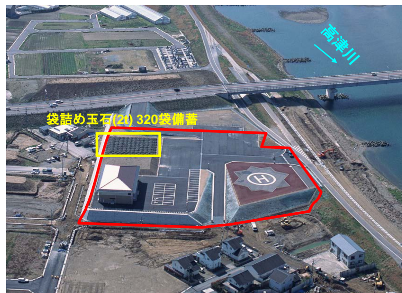
高津川河川防災ステーション(平成22年3月完成)
