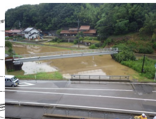
堤内地側浸水状況
