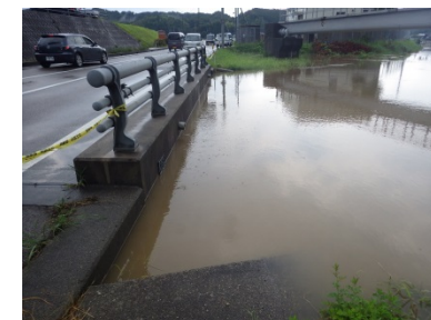
県道益田阿武線状況
