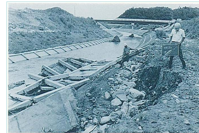
支川白上川の護岸損傷
