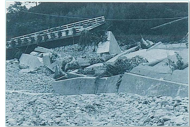
支川白上川の護岸損傷
