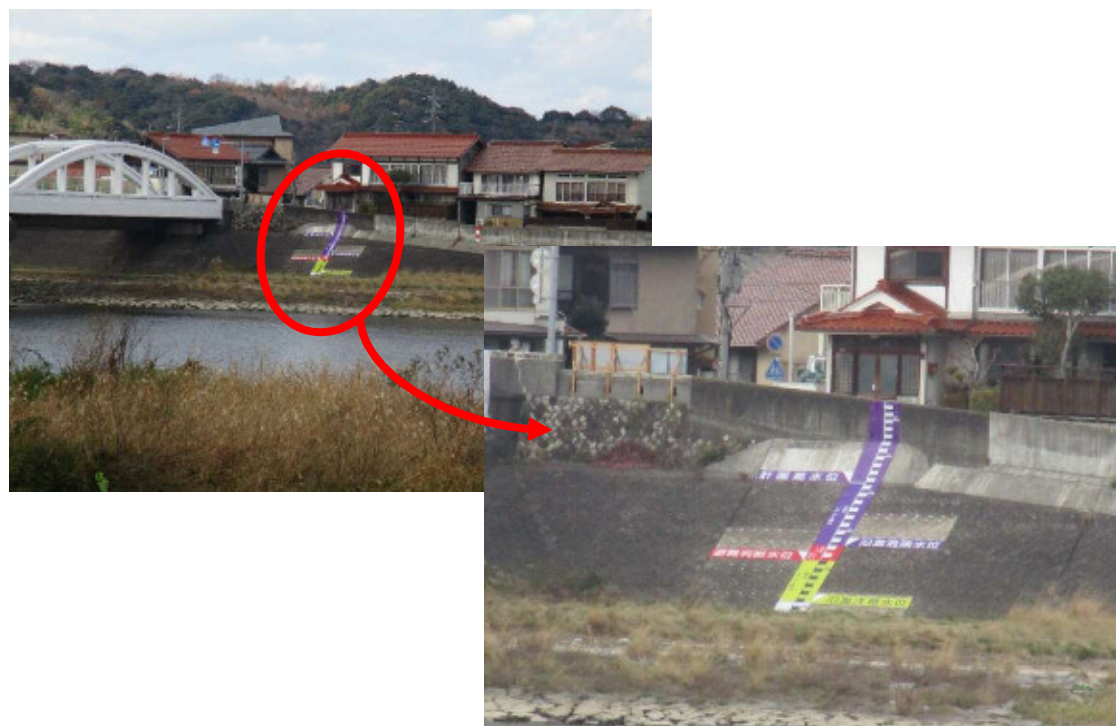
更新後の水位表示板（高津川高角橋）
