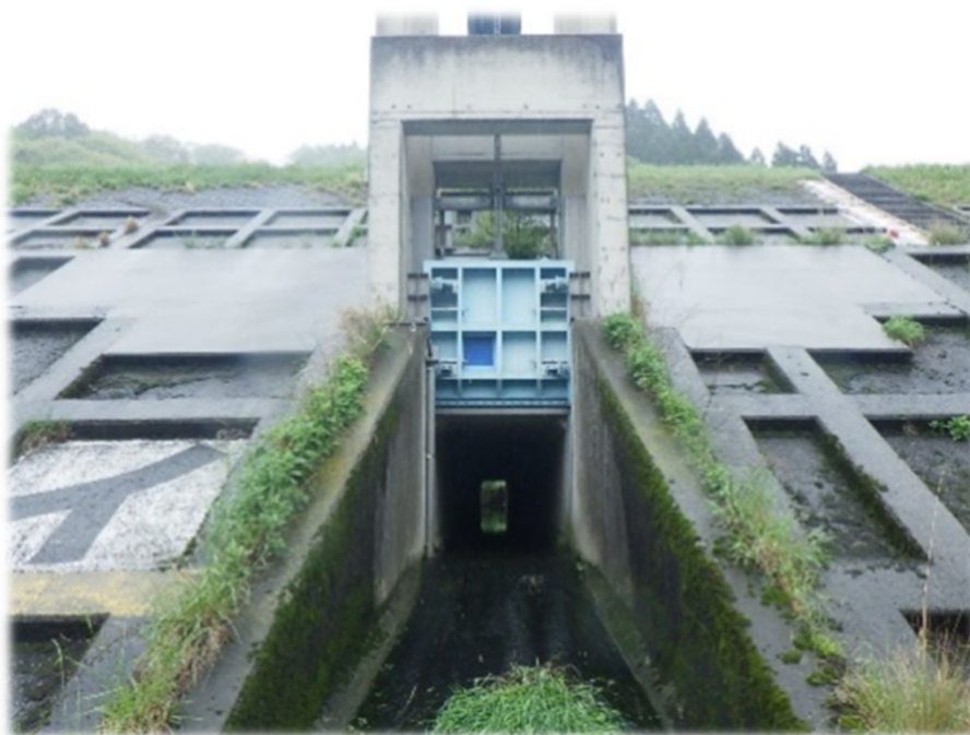
久座仁排水樋門(無動力化前)
