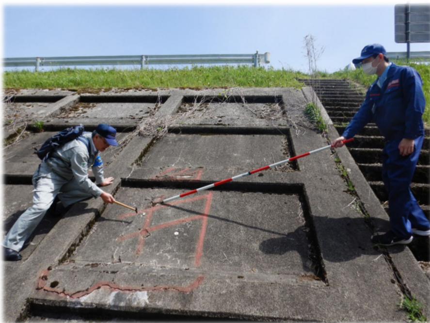
護岸の打音検査
