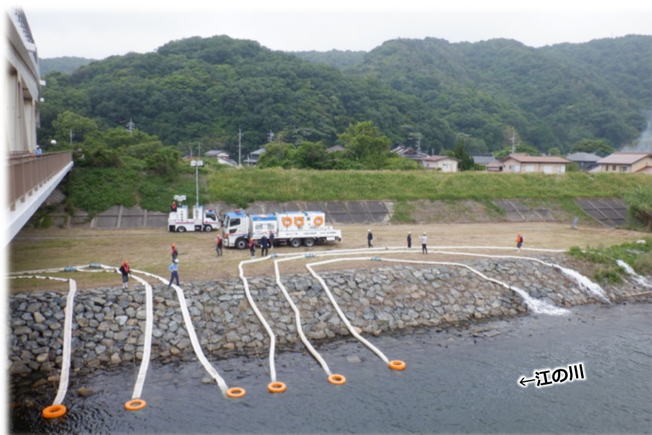
排水ポンプ車の操作訓練の様子 (江の川下流管内)
