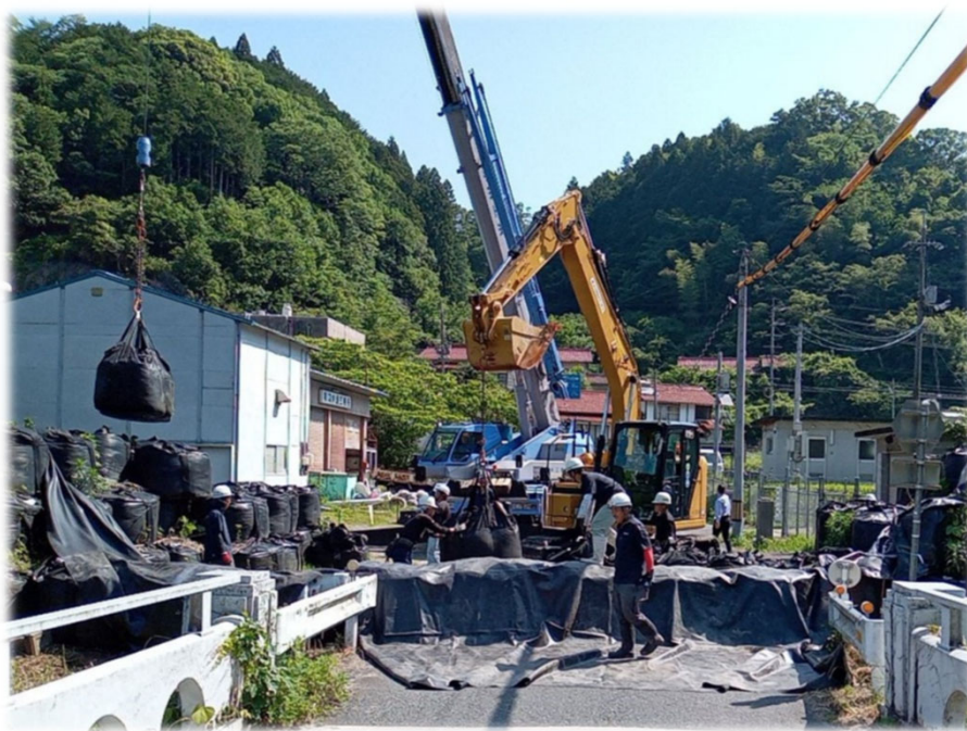
仮締切堤防の設置訓練の様子
