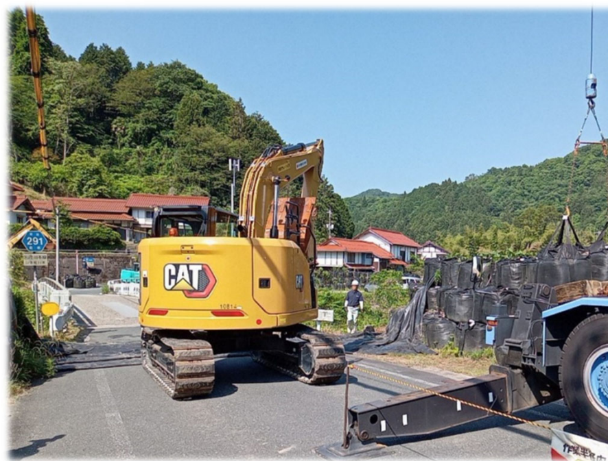
仮締切堤防の設置訓練の様子
