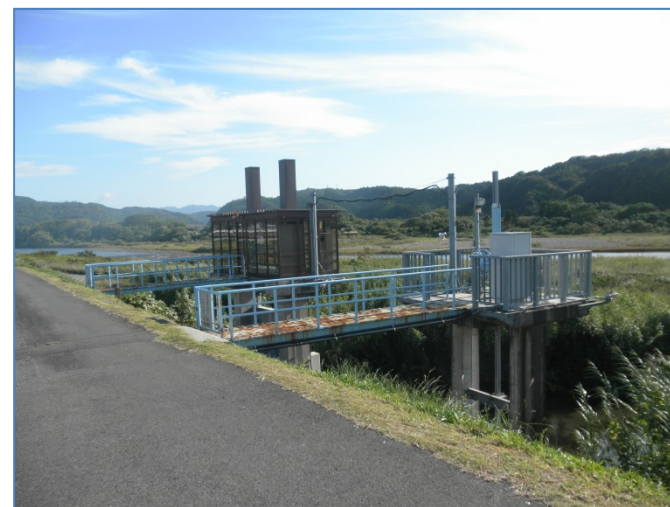
後川第1排水樋門・後川第2排水樋門
