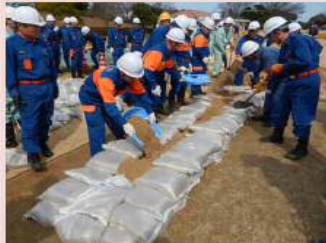
積み土のう工
