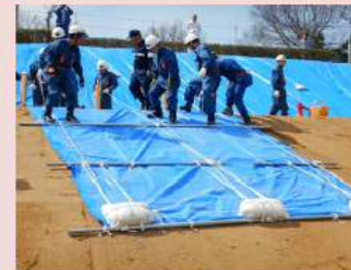
シート張り工
