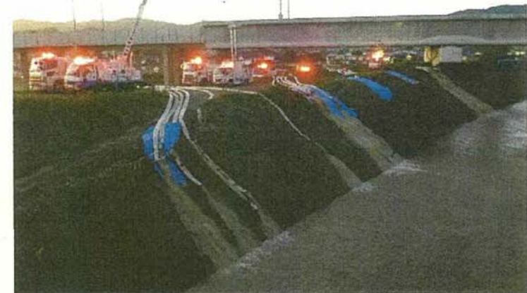
排水ポンプ車による排水作業
