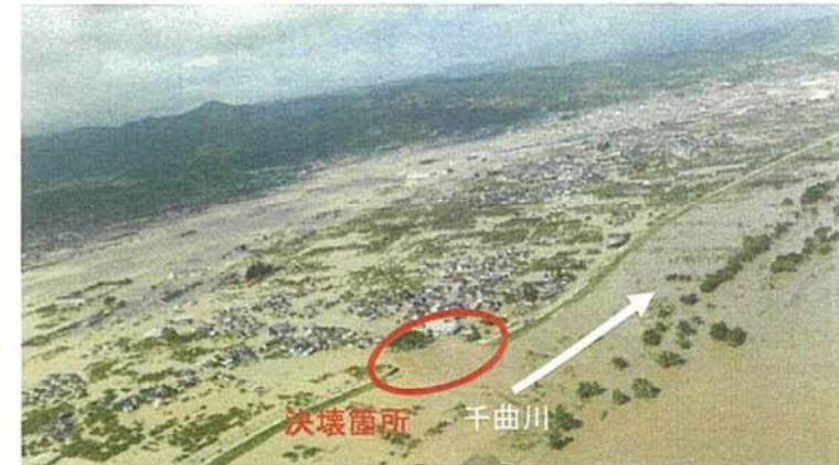
浸水状況(10月13日12時)
