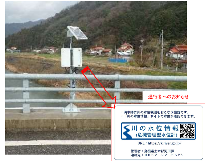
危機管理型水位計設置例
