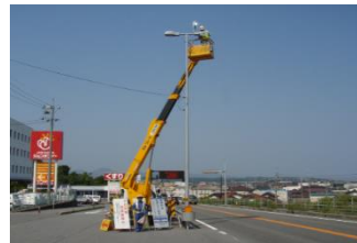
道路照明ランプ交換
