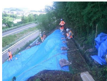
応急復旧作業
