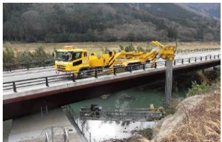
橋梁点検(1回/5年)
