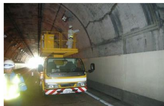
トンネル点検(1回/5年)
