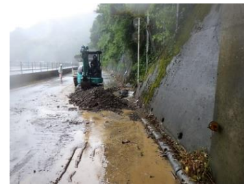
応急復旧作業
