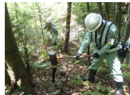
▲ 用地幅杭打設状況 (H30年5月～7月)
