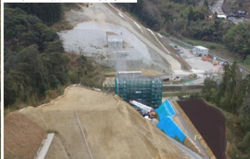
岡見川橋 (R4.3撮影)
