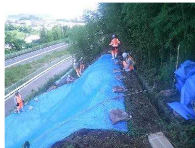
応急復旧作業
