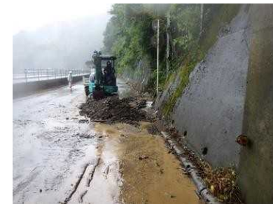
応急復旧作業
