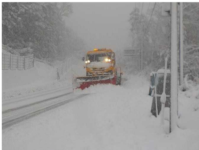
津和野町内での一般国道9号除雪作業
