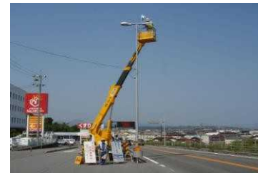
道路照明ランプ交換
