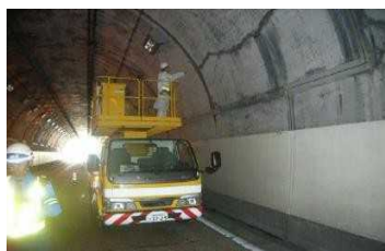
トンネル点検(1回/5年)
