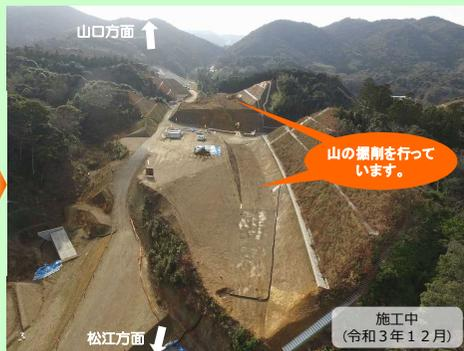
②金山地区第3改良工事 浜田市三隅町岡見地内で、盛土工事、山の掘削工事を行っています。
