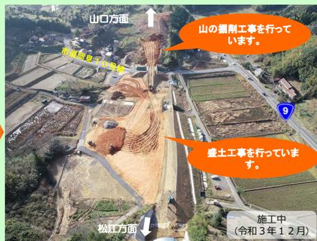
③大浜第2高架橋第2下部工事 益田市木部町地内で、大浜第2高架橋(仮称)の橋台(A1)1基と橋脚(P1、P2、P3)3基をつくっています。
