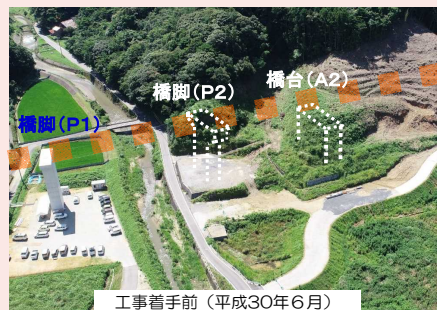
工事着手前 (平成30年6月)
