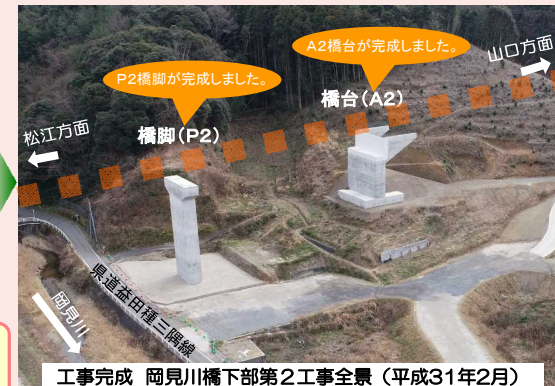
工事完成 岡見川橋下部第2工事全景 (平成31年2月)
