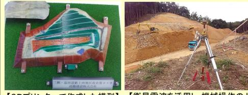
【3Dプリンターで作成した模型】 【衛星電波を活用し、機械操作のセミオート化を実現した「マシンコントロールバックホウ」による施工】
