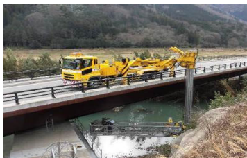
橋梁点検(1回/5年)
