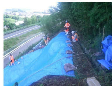
応急復旧作業
