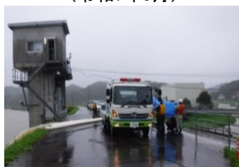
高津川排水ポンプ車稼働状況 (平成30年7月)
