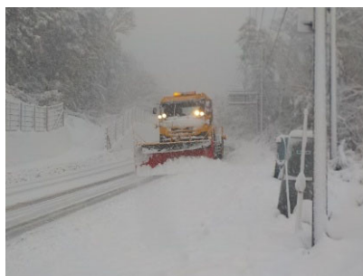
津和野町内での一般国道9号除雪作業
