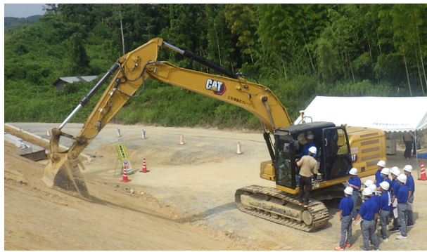
■現場見学会 建設機械の乗車体験(三隅・益田道路) : 島根県立翔陽高校
