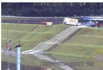
江の川排水ポンプ車稼働状況 (令和2年7月)
