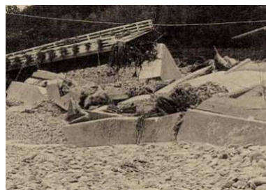
②昭和47年7月洪水による 派川虫追橋の被災状況
