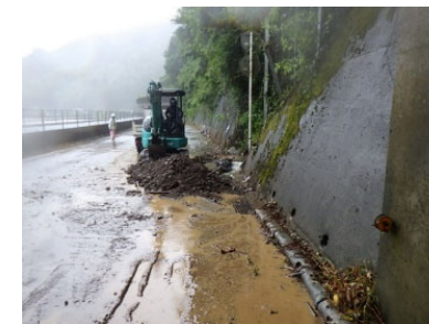
応急復旧作業
