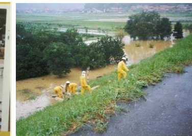
⑥平成9年7月洪水による 堤防法尻からの漏水対策
