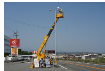
道路照明ランプ交換
