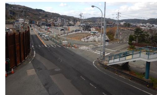
浜田市熱田町 (交差点改良・自転車歩行者道整備箇所)
