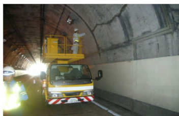
トンネル点検(1回/5年)
