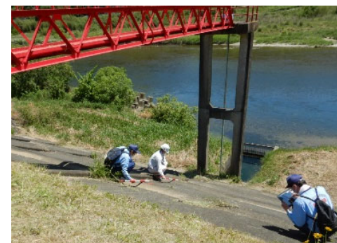
堤防点検状況
