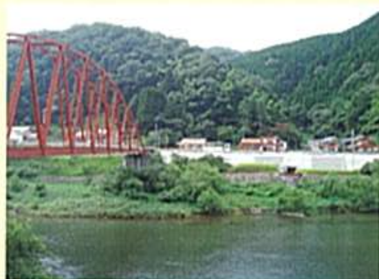
対岸より上ヶ畑地区を望む(三国橋下流)
