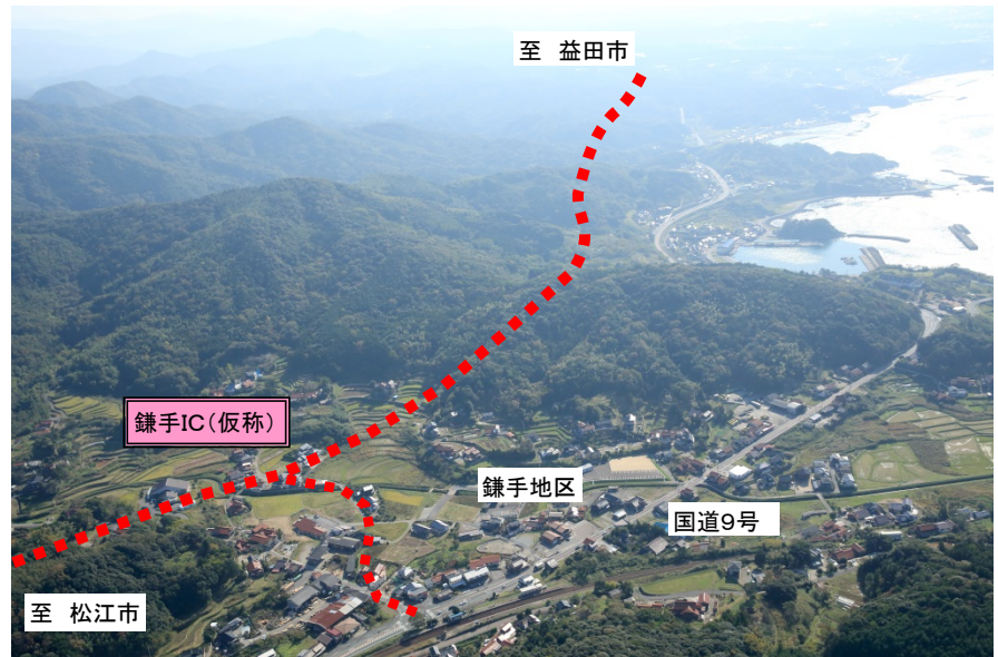
⑧ 鎌手地区から益田方面(鎌手IC(仮称))を望む
