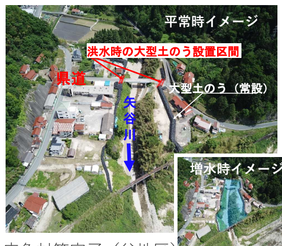
応急対策完了（谷地区）
