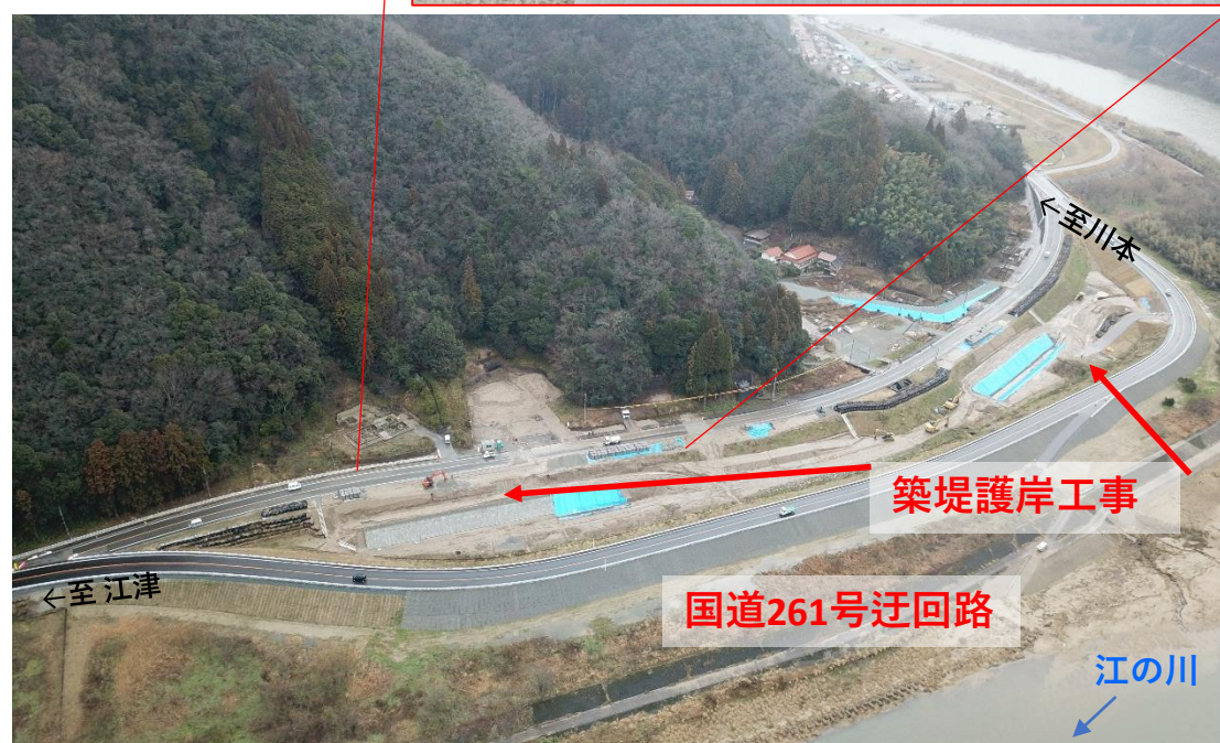
施工中(1月末時点)
