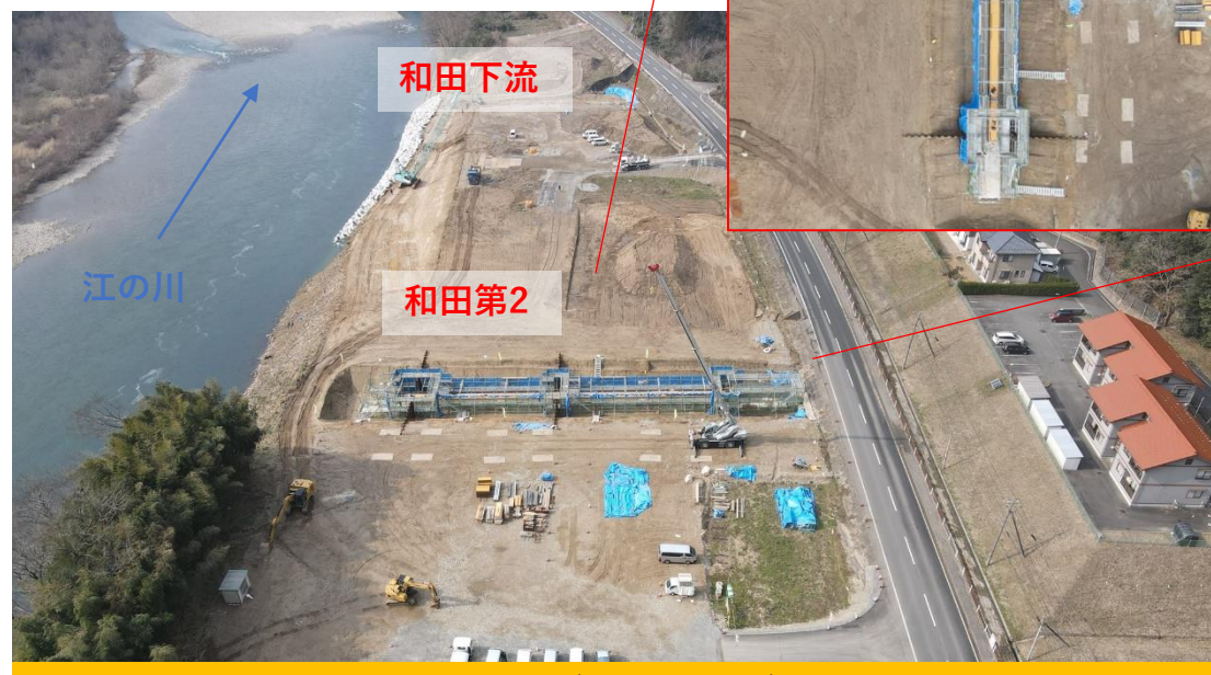
施工中(1月末時点)
