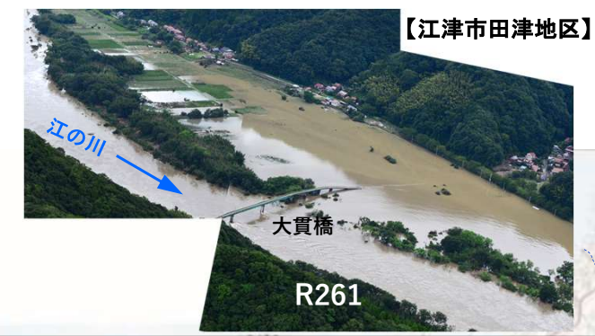
令和3年8月大雨による浸水状況
