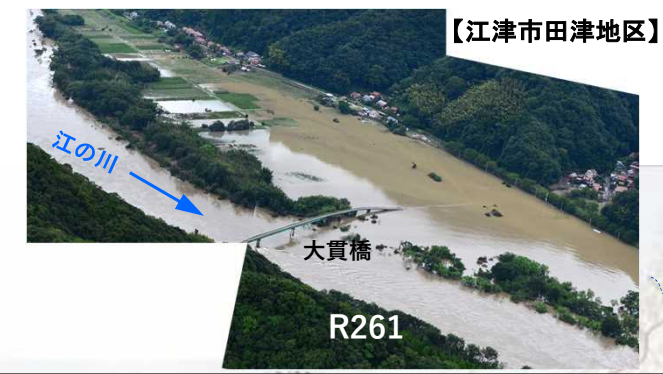
令和3年8月大雨による浸水状況
