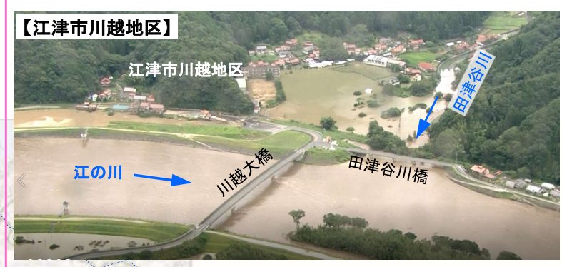
令和2年7月豪雨による浸水状況
