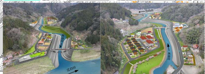
① 矢谷川下流から上流を望む
