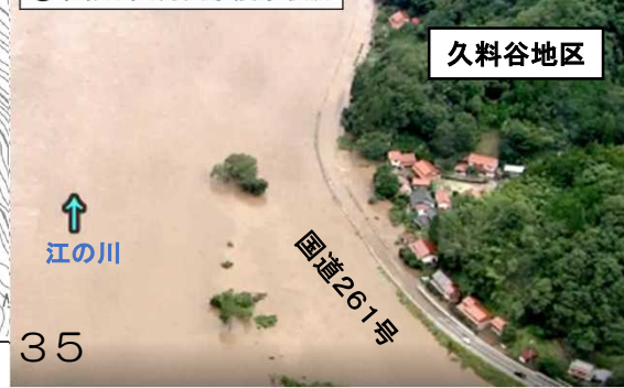
①令和2年7月出水浸水状況
