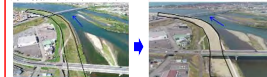
河道掘削事例（高津地区）
