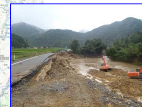
国道315被災状況
