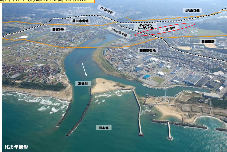
高津川下流部の市街化状況
