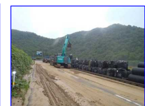
大型土のう搬入状況
