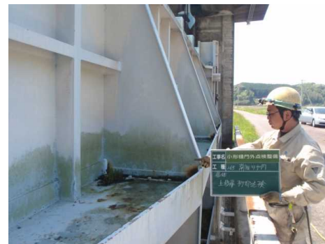
排水門等の点検状況
