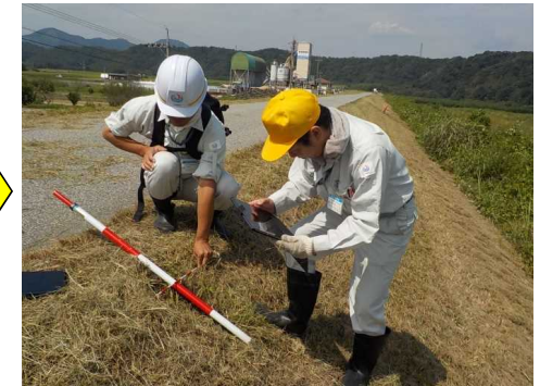
堤防点検状況
