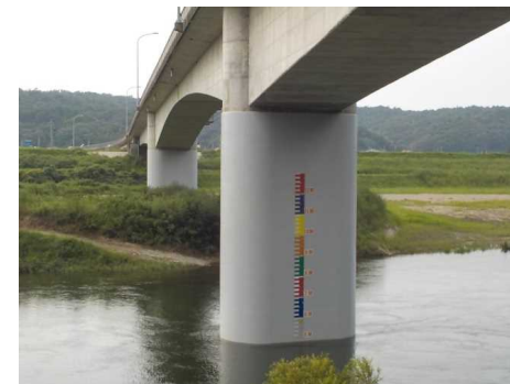
橋梁への量水標の設置
