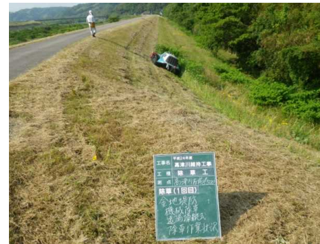
堤防除草状況
