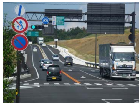
② 益田道路の状況(久城IC付近)
