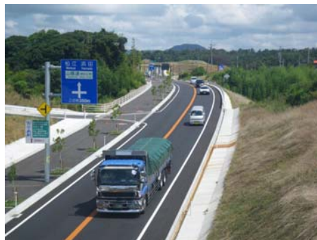
③ 県道久城インター線の状況
