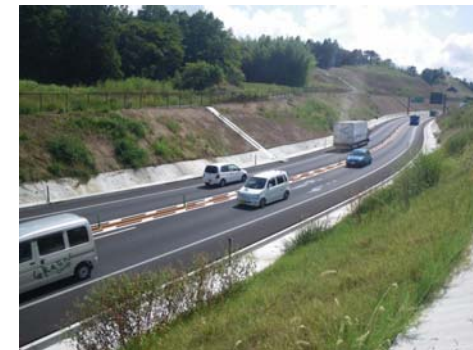
① 益田道路の状況(遠田IC付近)
