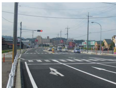
④ 市道中吉田久城線の状況
