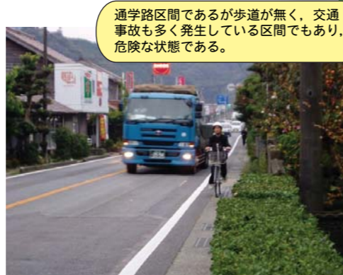
③⑧ 国道9号 益田市横田町：H22事業中
