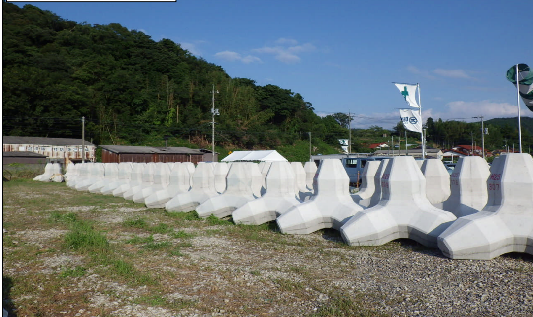
ブロック製作場所状況
